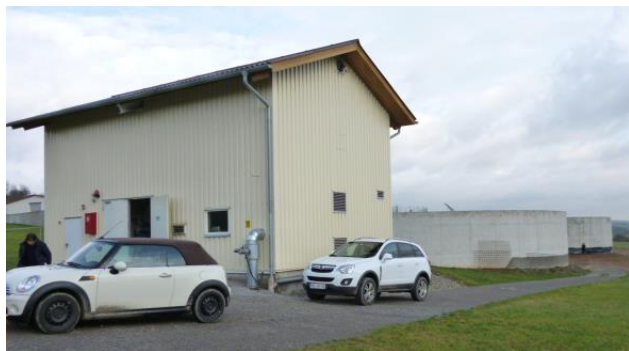
コンプレッサーステーション
