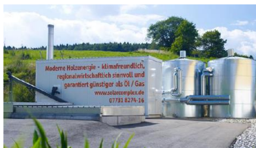
バイオガスプラント外観
