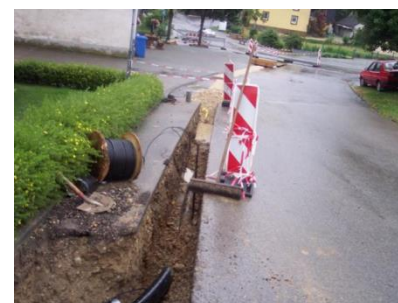
道路掘削配管工事
