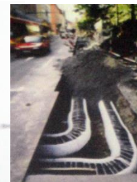
新規配管工事の様子
