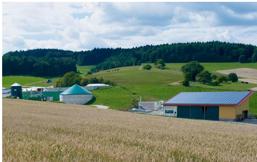
バイオガスプラント/太陽光発電
