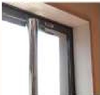
ガラスの表面にフィルムを貼り付け断熱性能をアップする
