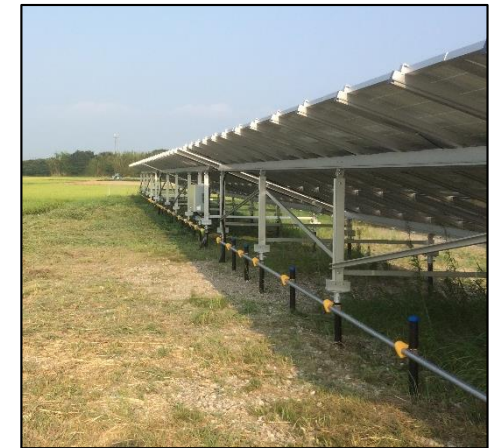
第二発電所最北架台 3 基の風圧荷重補強： 後列単管パイプ 2 m → 3 m に変更。 さらに各架台に補強用単管パイプ 2 m 支柱 6 本を追加埋設し、全支柱を単管 パイプと直交クランプにて横連結。
