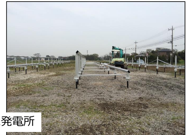
第二発電所最北架台 3 基の風圧荷重補強： 後列単管パイプ 2 m → 3 m に変更。 さらに各架台に補強用単管パイプ 2 m 支柱 6 本を追加埋設し、全支柱を単管 パイプと直交クランプにて横連結。
