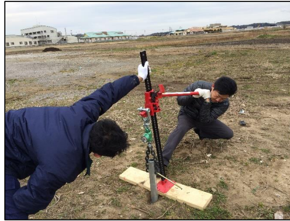
第二発電所計画地 引抜強度試験 2015/3/6
