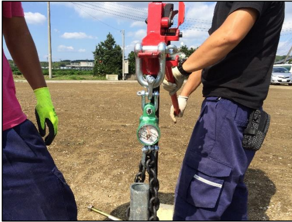
第一発電所計画地 引抜強度試験 2014/9/9, 19
