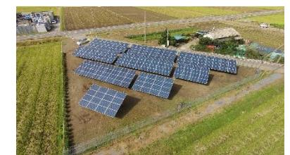
第二発電所と同じ50kW未満の低圧発電所ですが、太陽光パネルの枚数は第二発電所の288枚より少ない240枚=60kWです。
