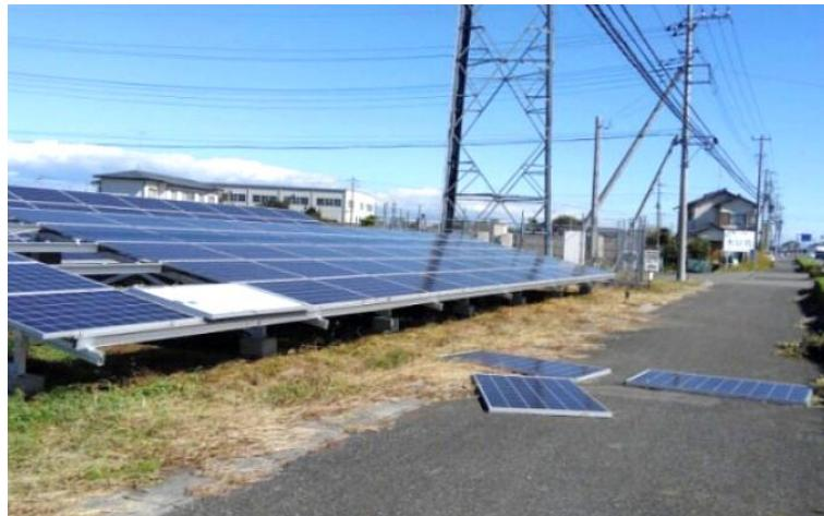
強風により太陽電池が構外へ飛散した他社事例
